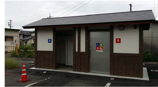
H25年春 本巣駅・北方真桑駅 新しいトイレ完成
